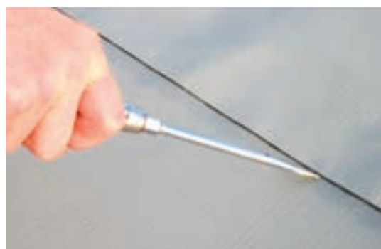
Рис. 5.2.8 Контроль при помощи плоскошлицевой отвертки
