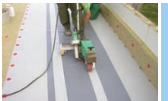
Рис. 3.6.9 Приварка автоматом полосы
