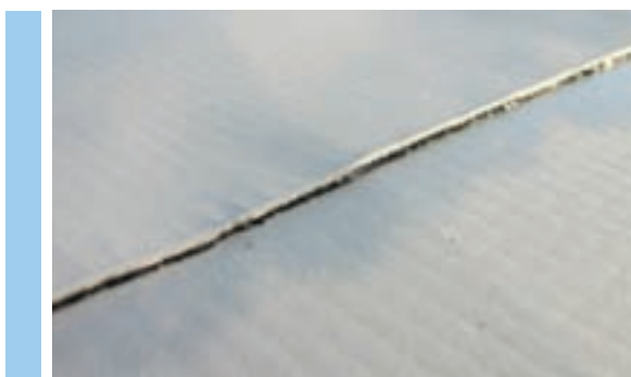
Рис. 5.2.4 Визуальная проверка качества сварного шва
