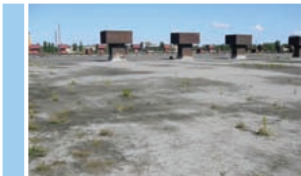
Рис. 2.6.1 Старая битумная кровля
