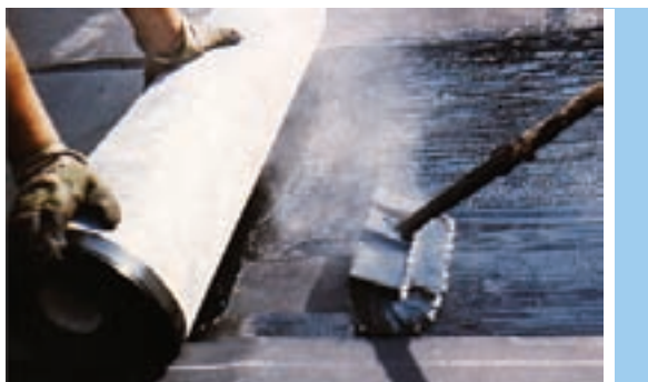
Рис. 5.4.5 Приклейка ТПО мембраны с подложкой на горячий битум
