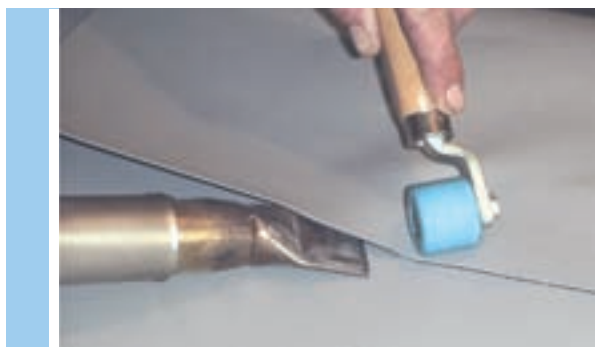
Рис. 5.2.7 Автоматическая и ручная сварка мембран
