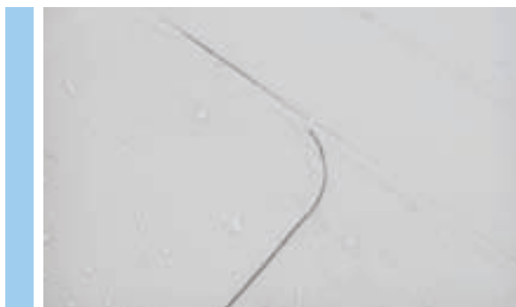
Рис. 5.4.1 Скругление углов мембраны
