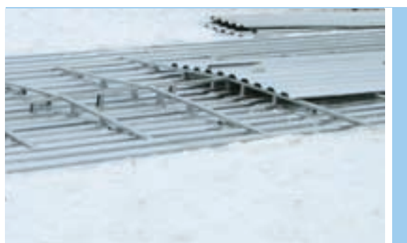
Рис. 3.3.4 Вариант устройства разуклонок
