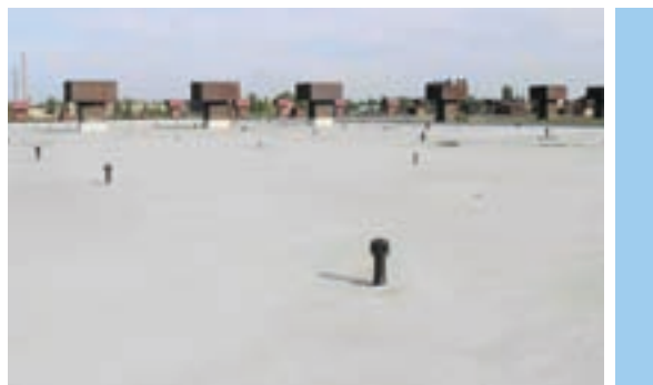
Рис. 2.6.2 Вид кровли после реконструкции полимерными мембранами с доутеплением
