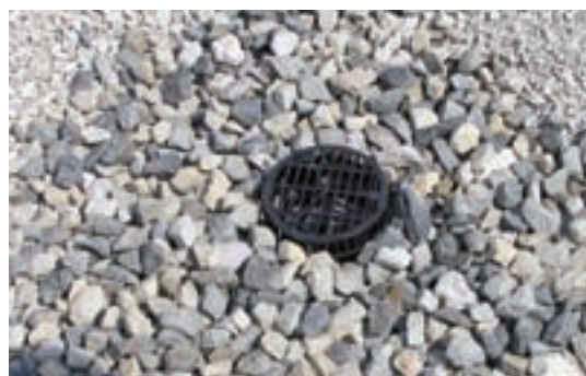
Рис. 2.4.5 Увеличение фракции балласта вокруг воронки
