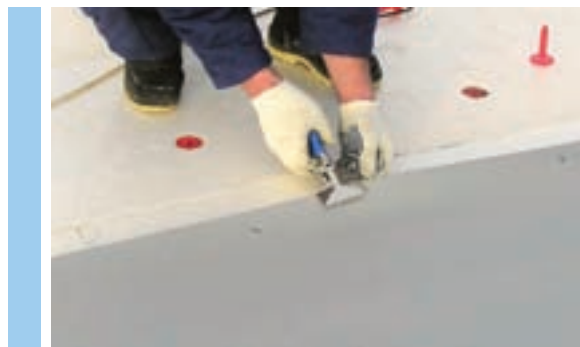
Рис. 5.4.3 Натяжение мембраны
