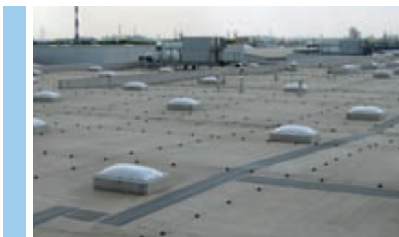
Рис. 3.6.4 Вид кровли с применением пешеходной дорожки ТехноНИКОЛЬ
