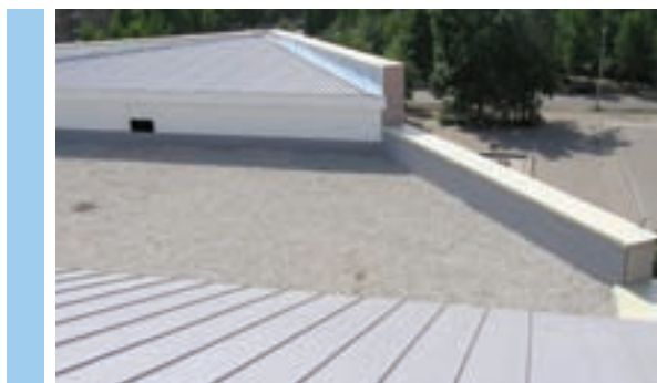
Рис. 2.4.1 Вид балластной кровли
