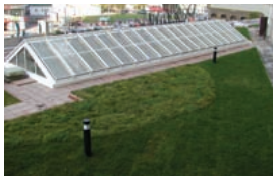
Рис.2.4.4 Вид «Зеленой» кровли
