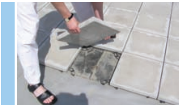
Рис. 2.4.3 Применение в качестве балласта тротуарной плитки
