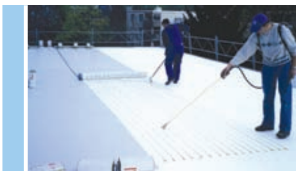
Рис. 2.6.3 Нанесение клея под полимерную мембрану с флисовой подложкой
