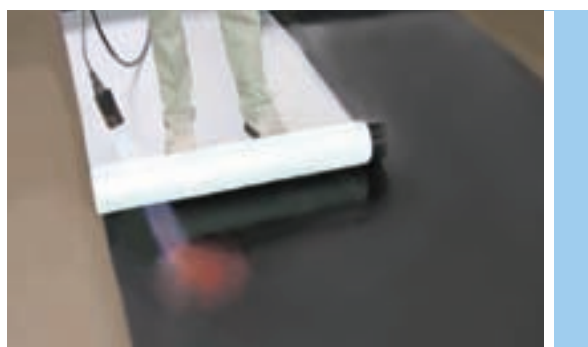
Рис. 2.6.4 Применение битумного материала в качестве монтажного клея
