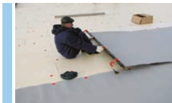
Рис. 5.4.4 Натяжение ТПО мембраны
