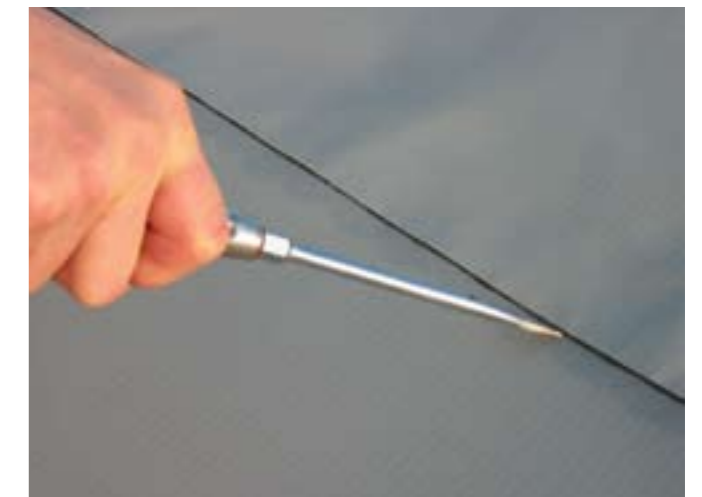
Рисунок 4.2.8 Проверка сварного шва при помощи отвертки.
