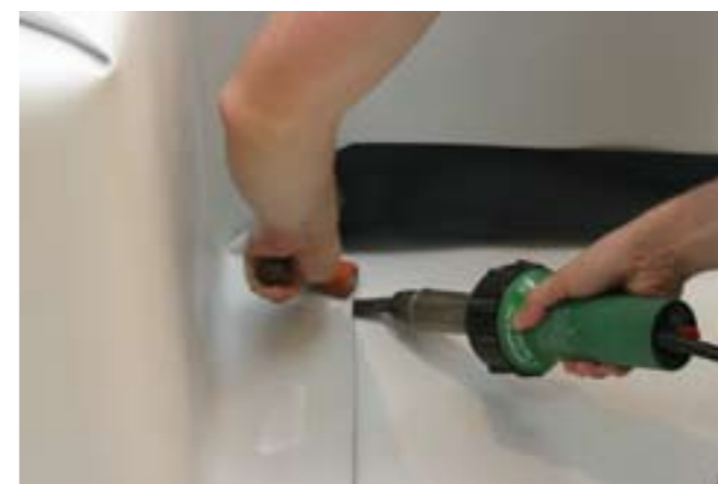
С помощью ручного фена приварить нахлест на горизонтальную часть слева. Ширина шва не менее 30мм
