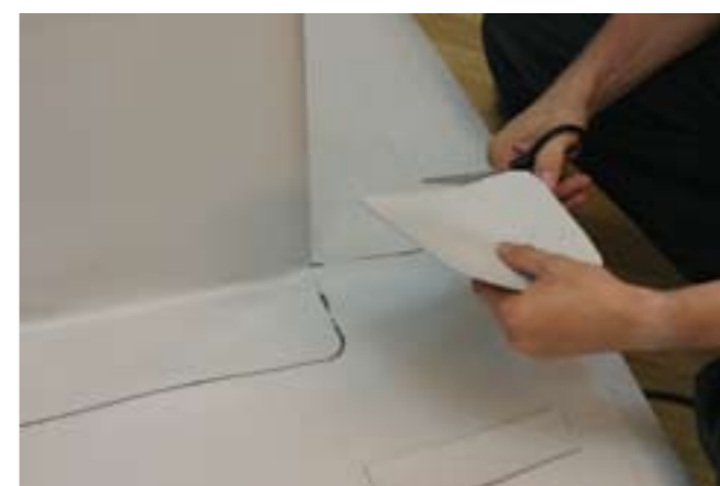
Из неармированного материала вырезать квадрат как показано на рисунке. Скруглить все углы.
