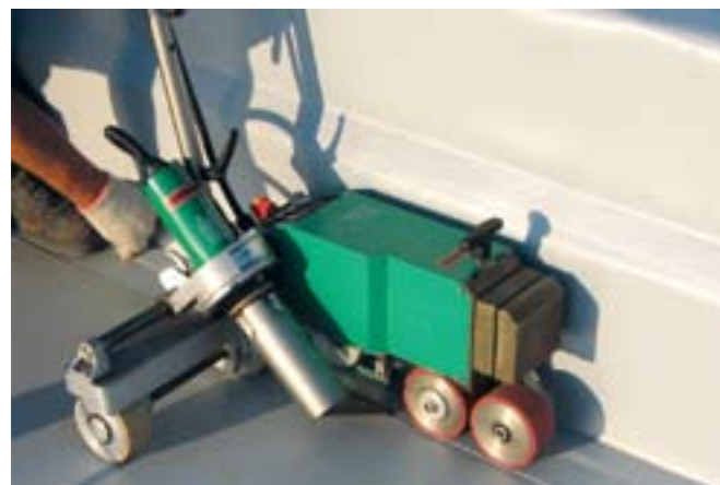
Горизонтальный нахлест мембраны приваривается сварочным автоматом.
