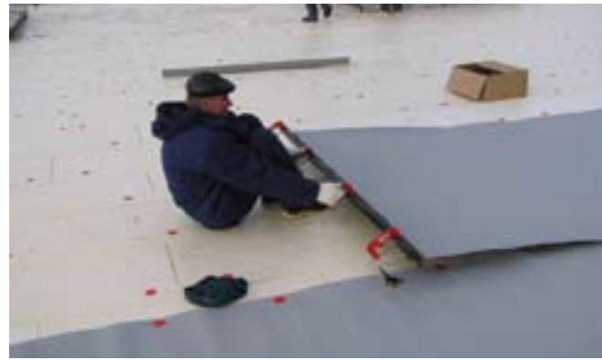
Рисунок 4.4.4 Натяжение ТПО-мембраны.
