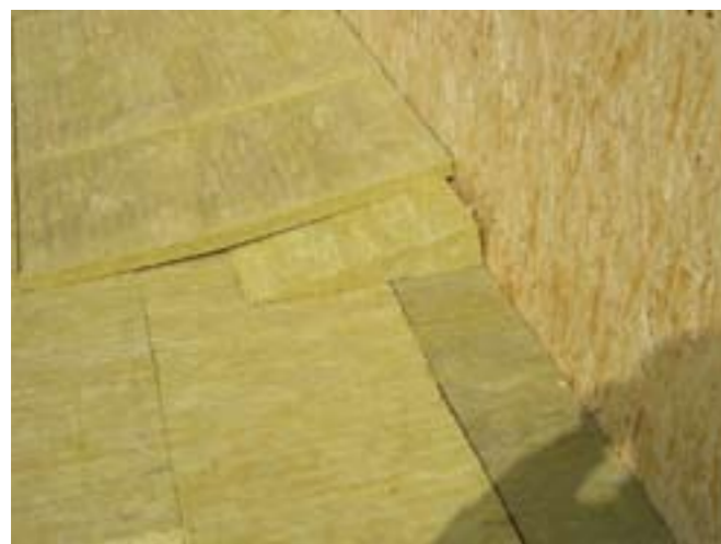
Рис. 2.3.1 Устройство контруклона клиновидным утеплителем.
