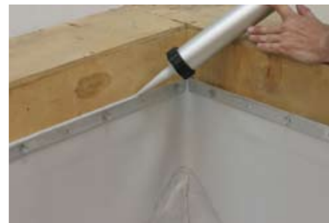
Заполнить поверхность отгиба рейки полиуретановым герметиком.
