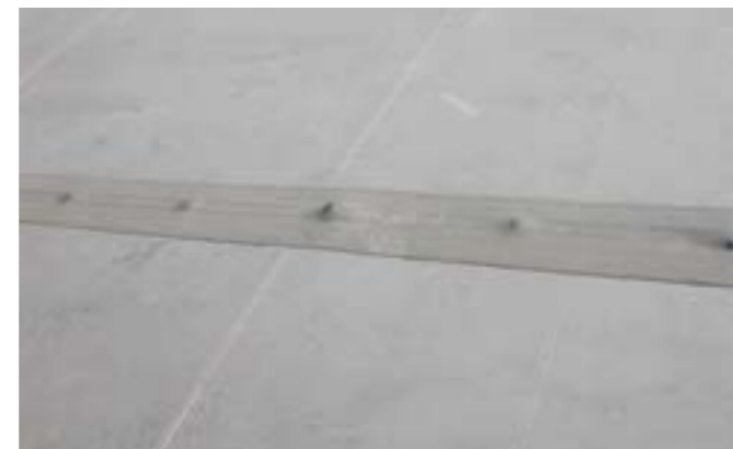
Рис. 2.5.11 Повреждение мембраны шляпкой самореза при применении линейных прижимных держателей без ребер жесткости.
