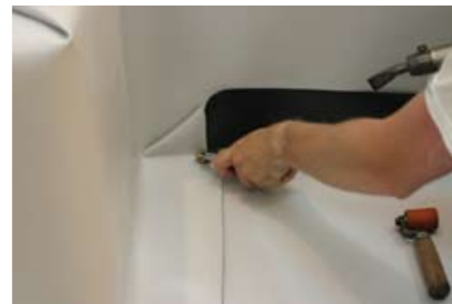
С помощью ручного фена заварить клапан угла по периметру. Ширина шва не менее 20 мм.
