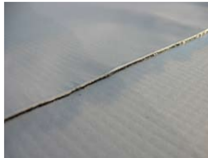
Рисунок 4.2.4 Визуальная проверка качества сварного шва.
