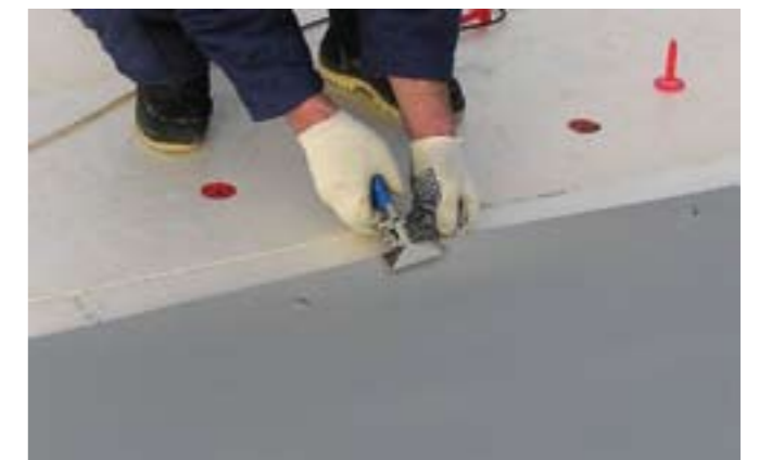
Рисунок 4.4.3 Натяжение мембраны.
