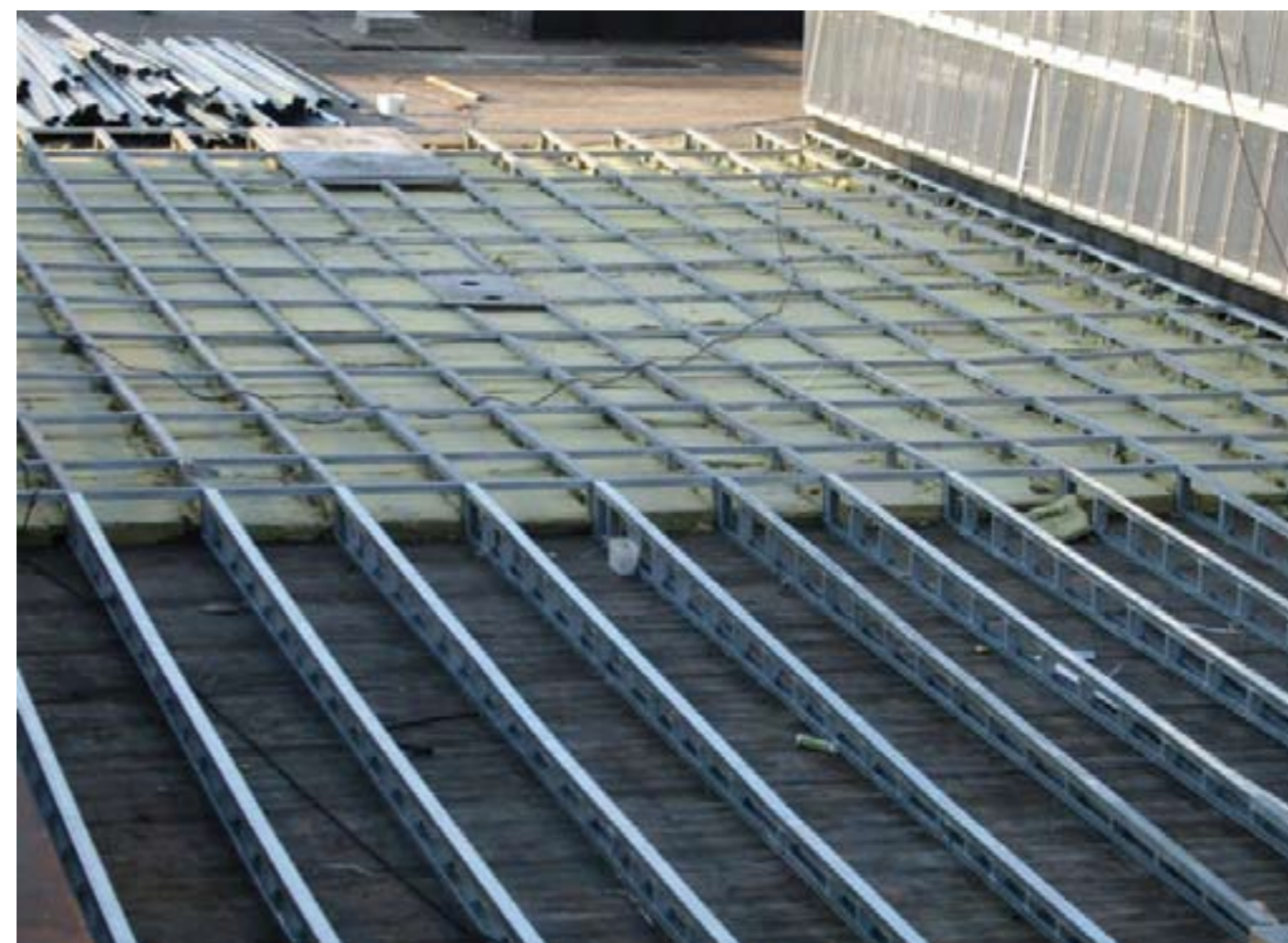
Рис. 2.3.3 Вариант устройства разуклонки.
