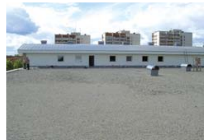
Рис. 1.1.2.1 Вид балластной кровли.
