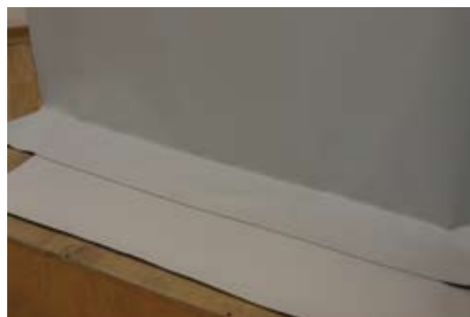
Мембрана заводится на вертикальную поверхность на высоту не менее 300 мм.
