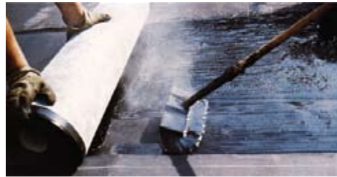
Рисунок 4.4.5 Приклейка ТПО-мембраны с подложкой на горячий битум.
