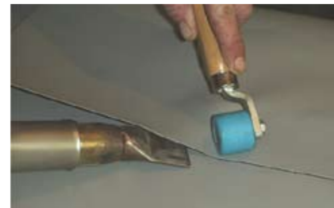
Рисунок 4.2.7 Автоматическая и ручная сварка мембран.
