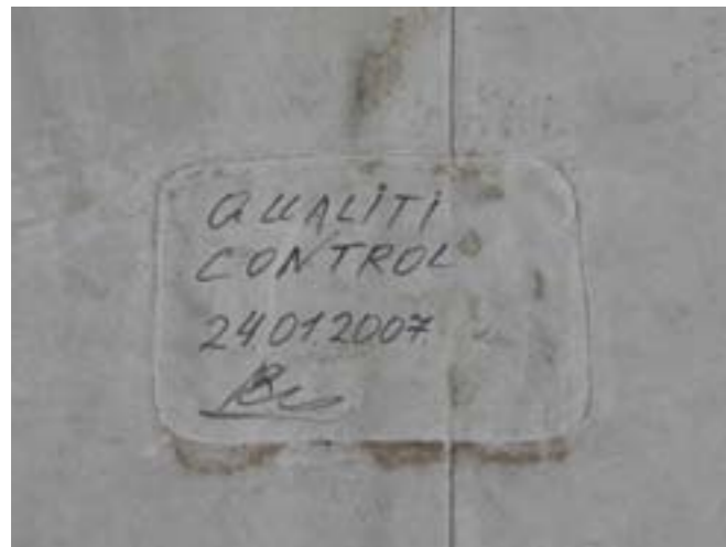
Рисунок 4.2.10 Контроль качества сварного шва.
