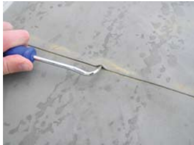
Рисунок 4.2.9 Проверка сварного шва при помощи чертилки.
