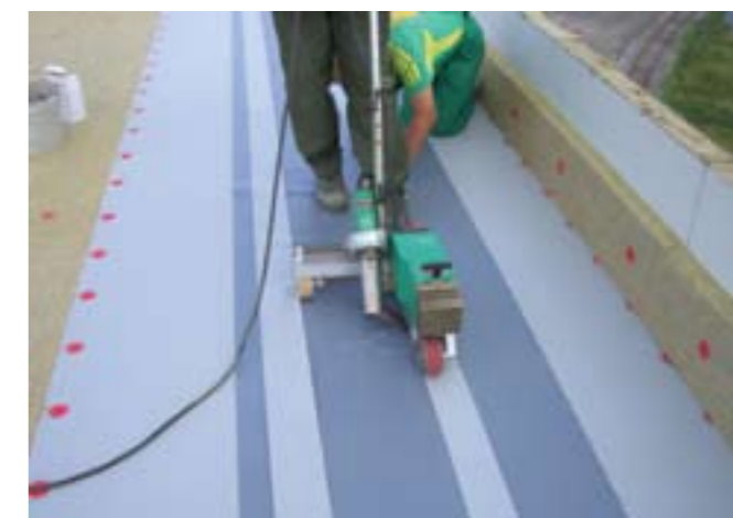
Рисунок 2.6.7 Приварка автоматом полосы.
