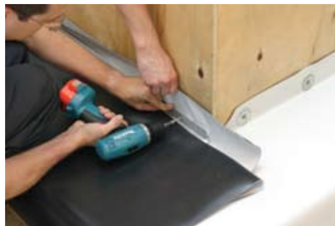
Прижимную рейку прикручивают к парапету.
